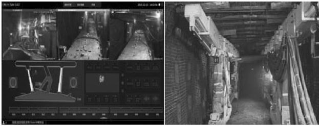
(a) 实景图 (b) 远程控制界面 图7 超前支架实景图及远程控制界面
