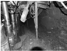
图 6 冲击地压破坏情况
